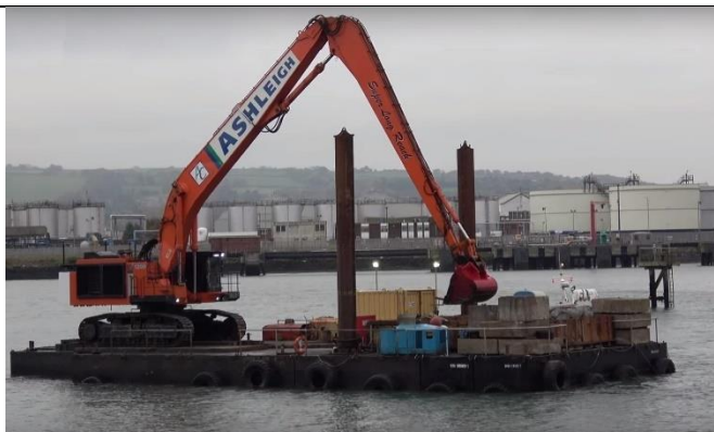
Photo 9 : Excavatrice sur ponton flottant
