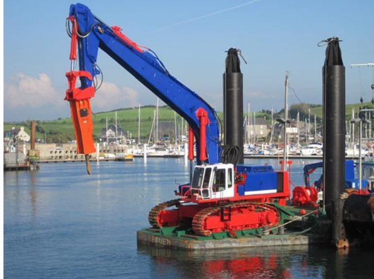
Photo 19 : Marteau piqueur pneumatique sur excavatrice
