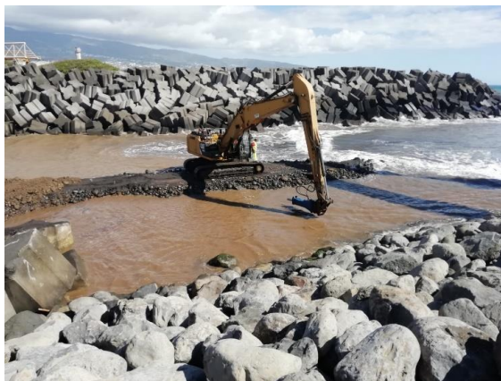
Photo 10: Pelle terrestre à bras long
